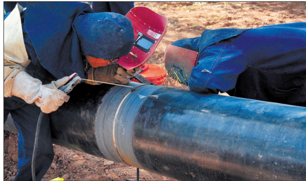
工人们正在焊接管道。
