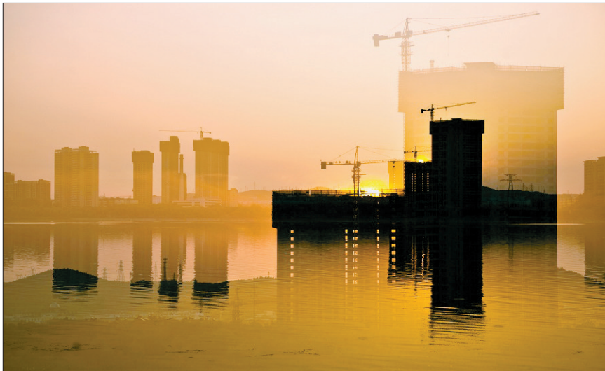
洛河岸边诸多新楼盘正在建设中。 王琳 摄
