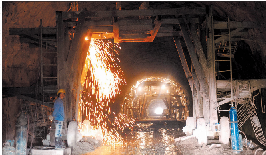
隧道内火花飞溅施工忙。
