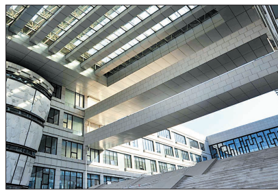
外立面采用高透光玻璃,尽可能利用自然光。
