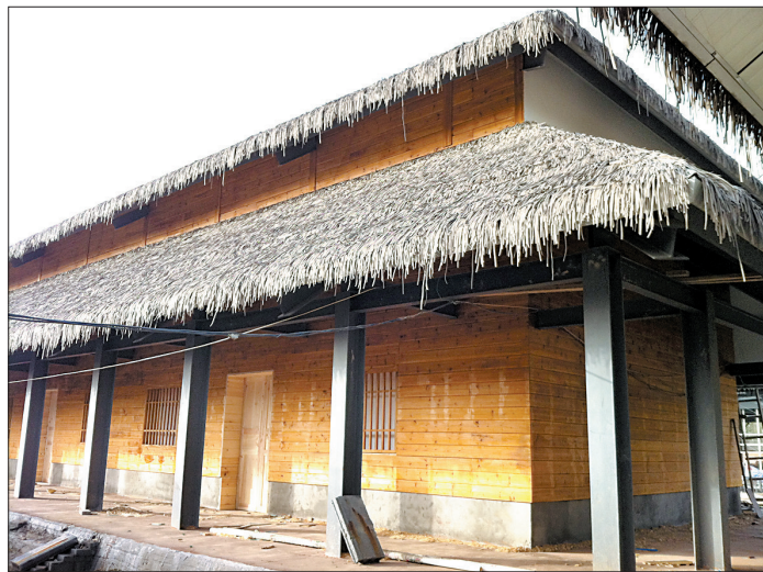
复建的宫殿采用钢架结构,顶部覆盖着仿真茅草,力求还原当时建筑的模样。
