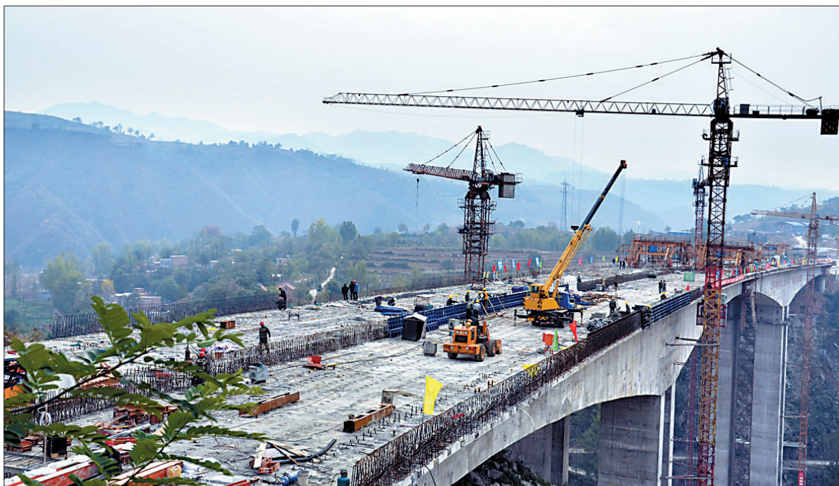
工人们正在栗子坪特大桥施工现场紧张施工。
