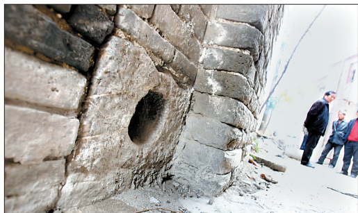
门楼下方过道两侧各有一个大门门臼。
