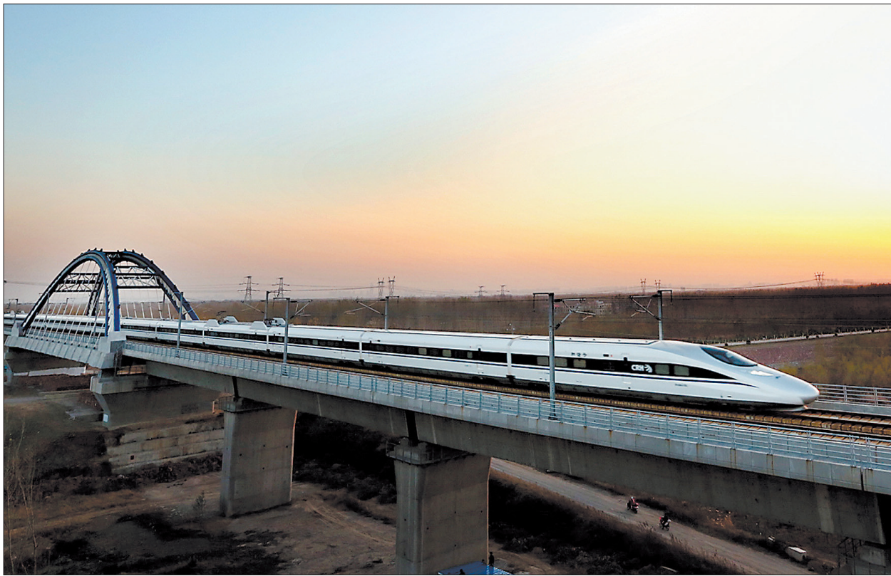
25日,一列和谐号动车组列车行驶在郑州黄河公铁两用大桥上。
