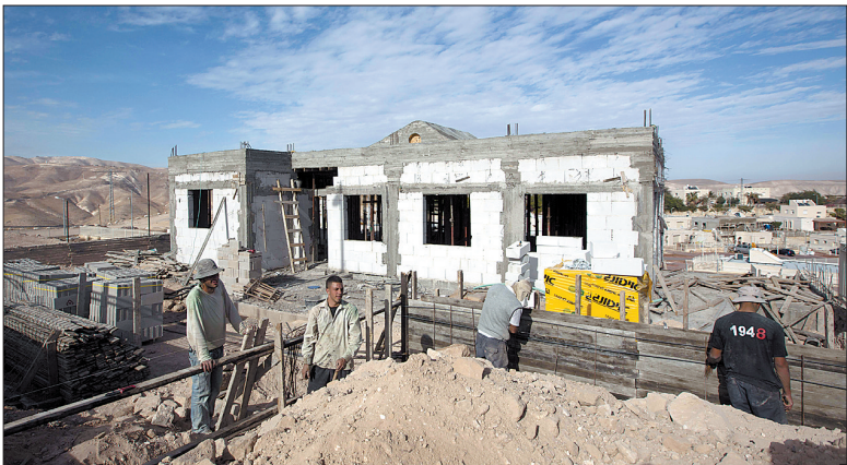
12月3日,在耶路撒冷附近的约旦河西岸犹太人定居点阿隆,巴勒斯坦工人在建筑工地工作。此前,以色列总理内塔尼亚胡在内阁例会上宣称将继续修建犹太人定居点。(新华社/法新)
