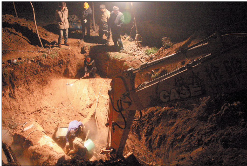
坑外,穿着棉衣都觉得寒风刺骨;坑里,维修人员的脚快被热水“煮熟”了。
