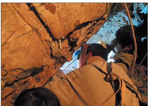
用电焊对故障管道进行抢修。
