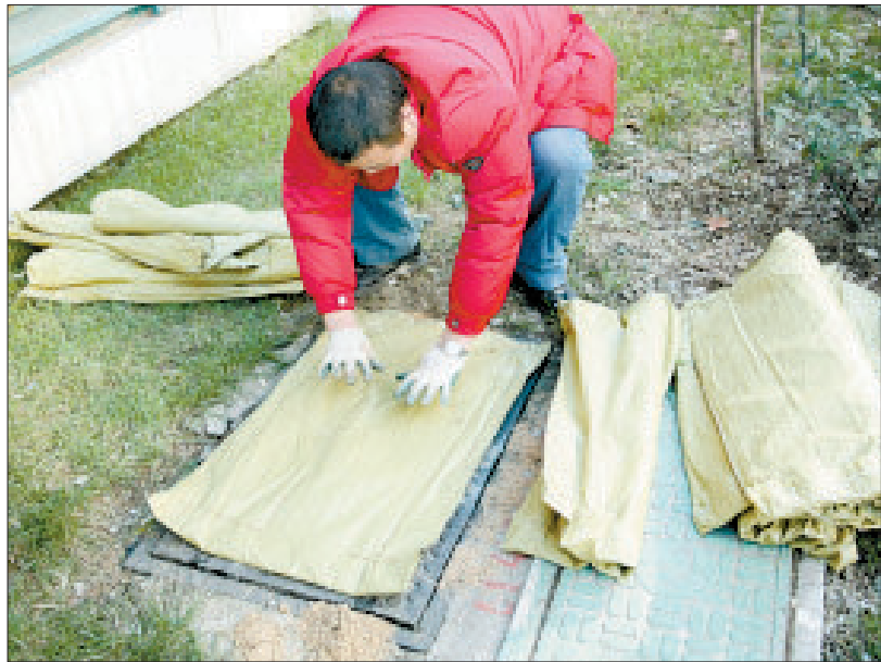
在水表井内填放锯末并盖草苫,可有效防止水表冻裂。(网络图片)
