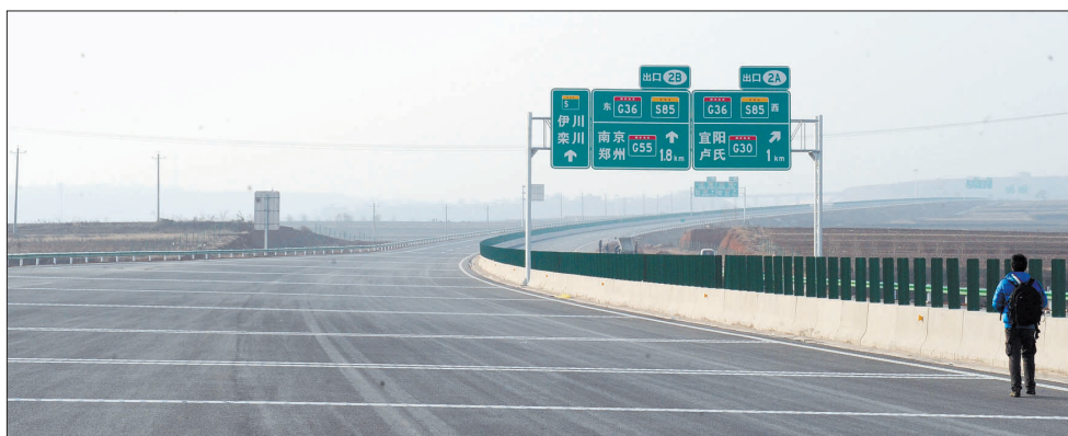
洛栾高速起点路标、路牌等均已安装到位
