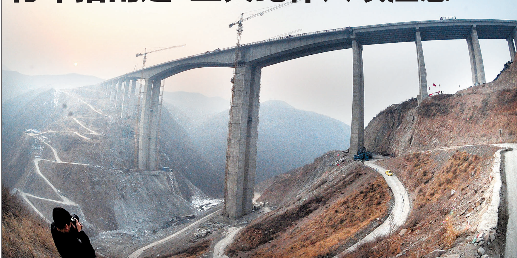
郑卢高速最高桥梁——大铁沟特大桥，桥面距谷底达200米
