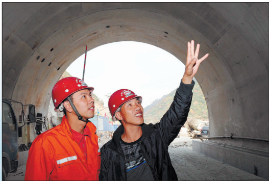
洛栾高速栾川段的施工人员正在看自己打通的隧道 (10月19日摄)
