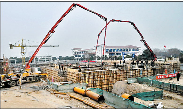
建设者们正紧张施工
