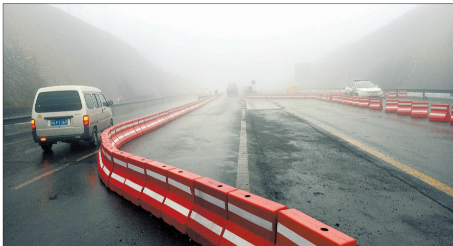
大桥北半幅已被隔离设施隔成两条车道
