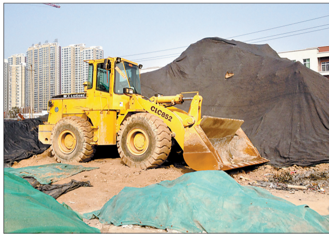
在一处工地,施工方按照有关规定对工地上露天堆放的黄土进行覆盖
