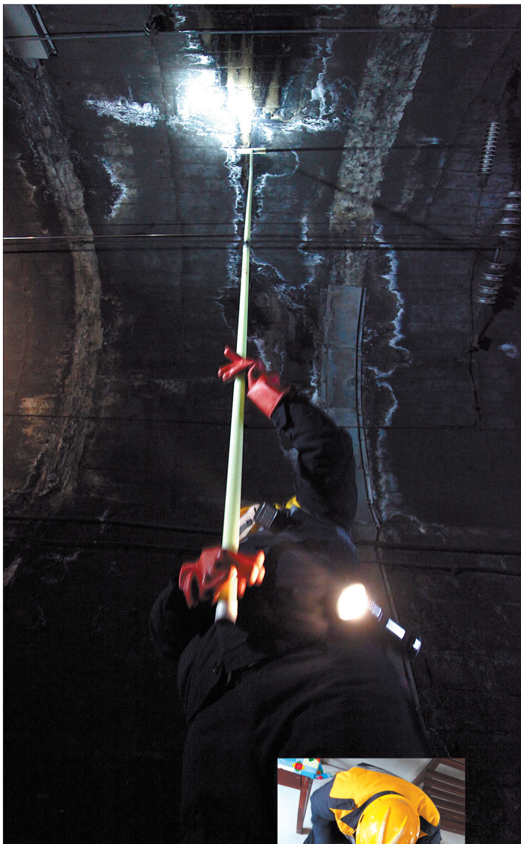
▲出发前,给绝缘杆作绝缘测试
