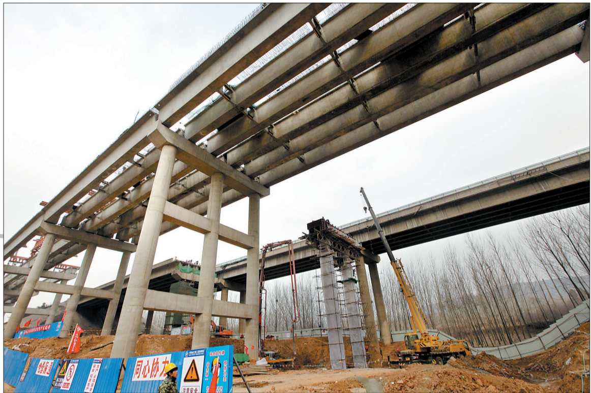
新桥即将合龙,老桥南半幅受损的桥墩也正在施工
