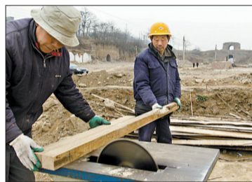
工人们正在施工
