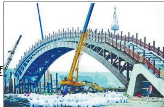
用木头可以造多大的桥?在苏州胥口的胥江古运河上,一座单跨跨度达75.7米的木拱桥给出了答案。这座主体结构刚刚完工的木拱桥突破传统木结构建筑理念,成为目前世界上跨度最大的木结构拱桥。经过业内人士测试,这座木拱桥的载重能力为195吨,相当于3000人同时站在上面,木拱桥都岿然不动。
