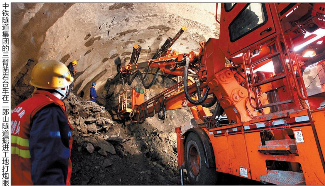
中铁隧道集团的三臂凿岩台车在二郎山隧道掘进工地打炮眼
