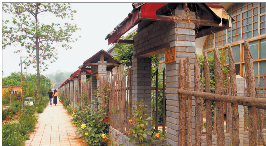
位于樱桃沟的养老养生基地新式窑洞房舍
