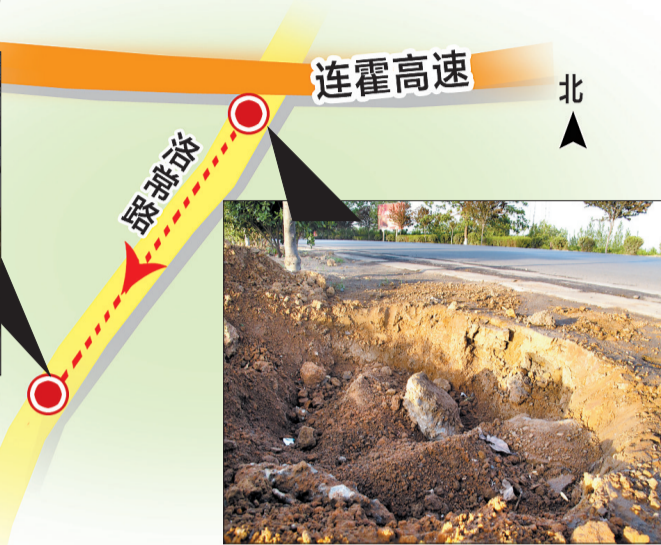
公交站牌原来的位置留下一个大坑
