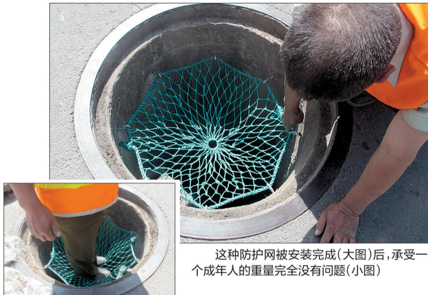
这种防护网被安装完成(大图)后,承受一个成年人的重量完全没有问题(小图)
