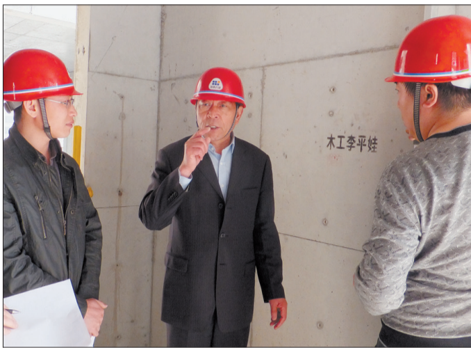
徐景月(中)正在指导工程建设
