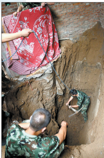
清除井壁周围的土
