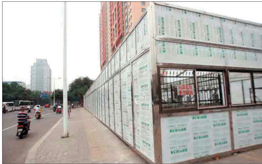
透过玻璃窗能看到里面的防护栏
