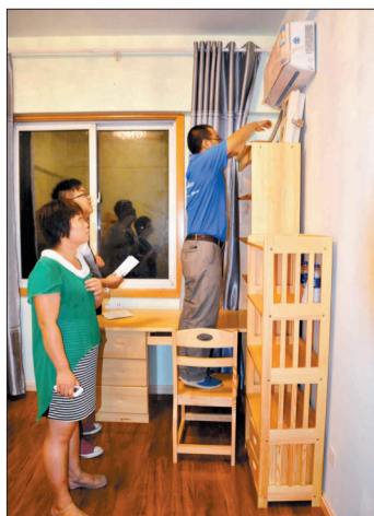
美的空调售后人员正在安装测量电表
