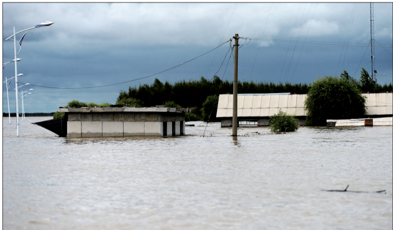
同江市八岔地区被洪水淹没的房屋 (新华社)
