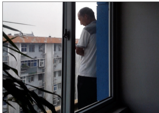
广告安装工人被困阳台
