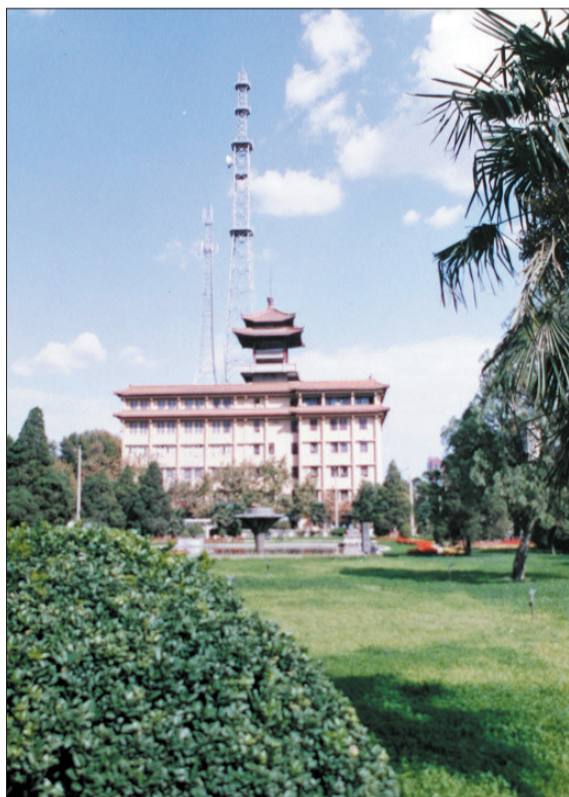
原来的洛阳邮电大楼
