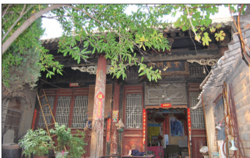
悬挂“望重折冲”匾额的院落
