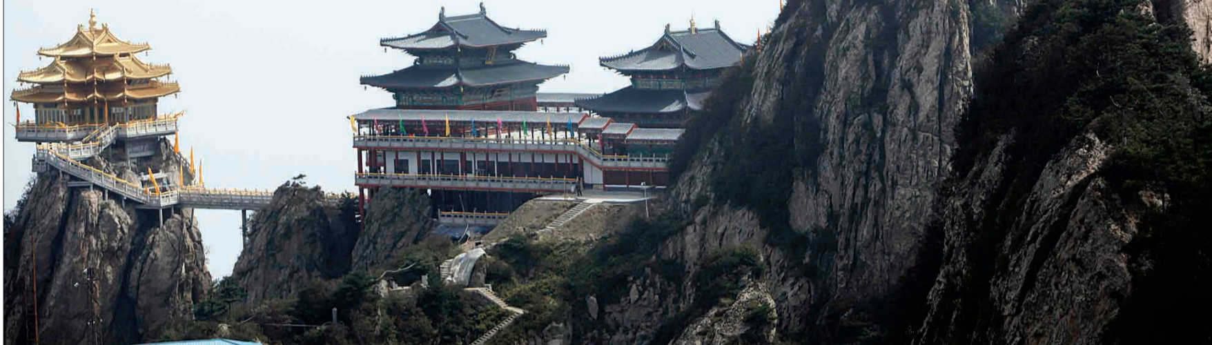
已建成的金顶道观群
