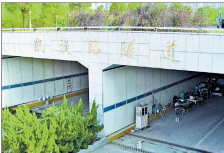
隧道内堆放着大量生活用品
