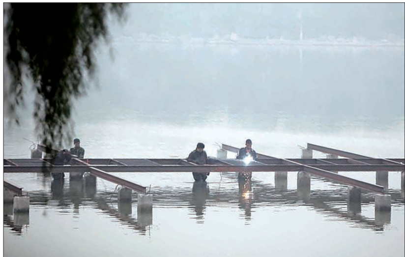
工人们正在进行焊接作业
