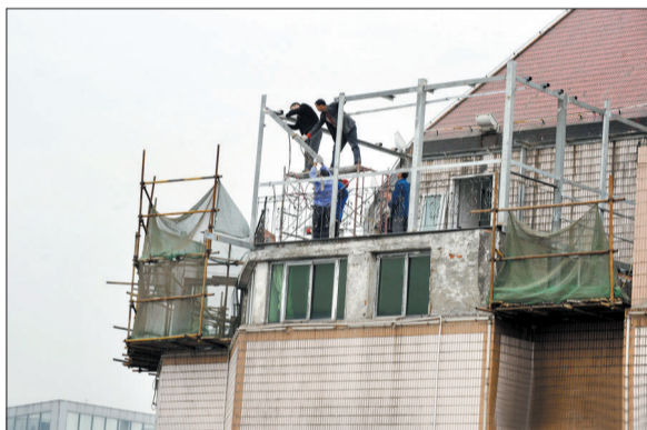
武汉城管执法人员拆除楼顶违建 (网络图片)
