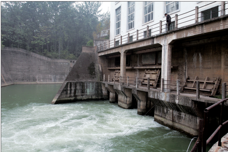
陆浑水库主千渠向下游灌区供水
