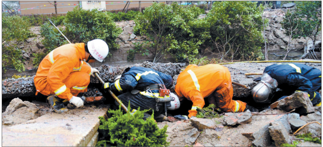
消防人员正在事故现场进行搜救
