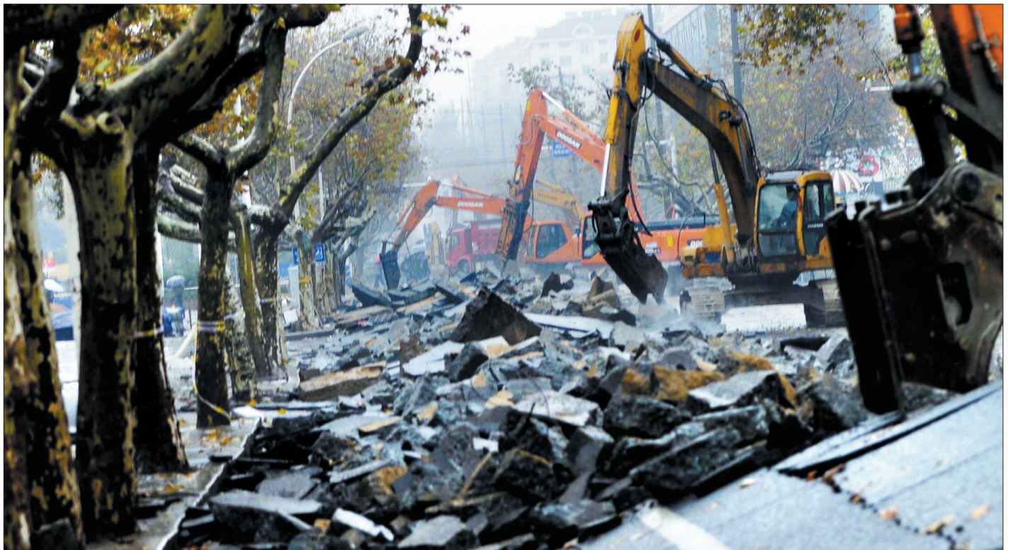
施工机械在破拆被炸毁的路面 (新华社发)
