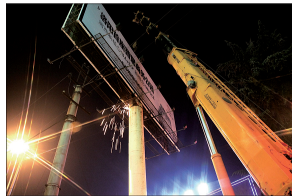
出动大吊车,拆除广告牌
