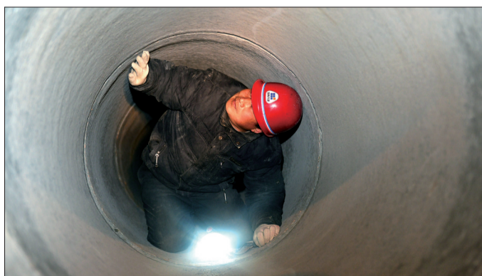
铺设污水管道
