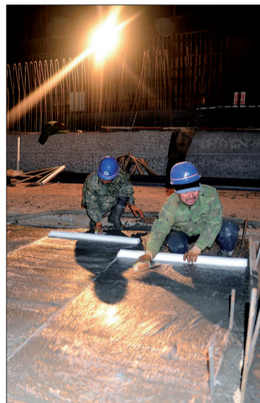
对混凝土进行收面作业
