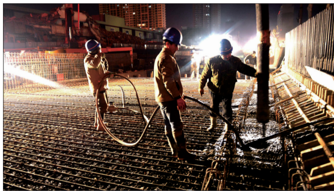
浇筑混凝土
