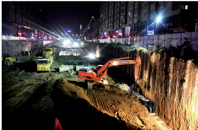
深夜,施工现场灯火通明
