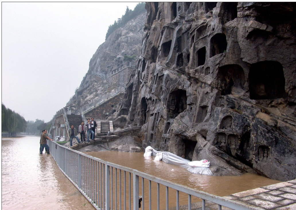
用塑料布和沙袋围挡洞窟,以防河水进入 (本组图片均为资料图片)
