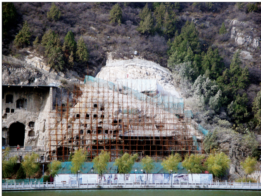
潜溪寺施工现场
