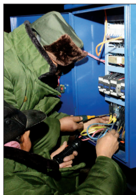
连接造雪机电源
