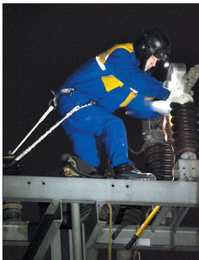
擦拭接触网上的绝缘子
