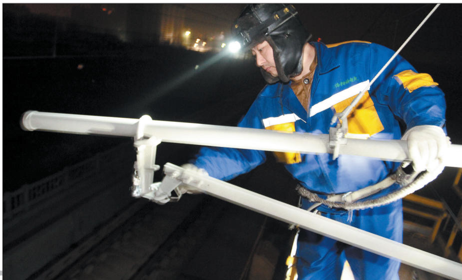
检查定位装置上的螺栓
