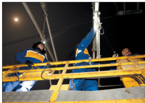
擦拭接触网上的绝缘子
