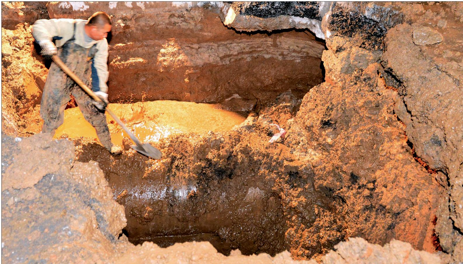
为既能尽快找到漏水点又不破坏供水管道,施工人员抡起铁锹人工挖坑
