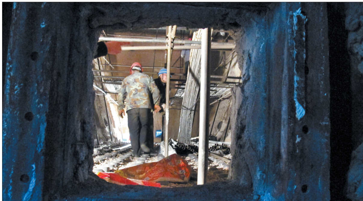
一号锅炉炉膛内,工人正在搭设脚手架,为维修过热器管道作准备
