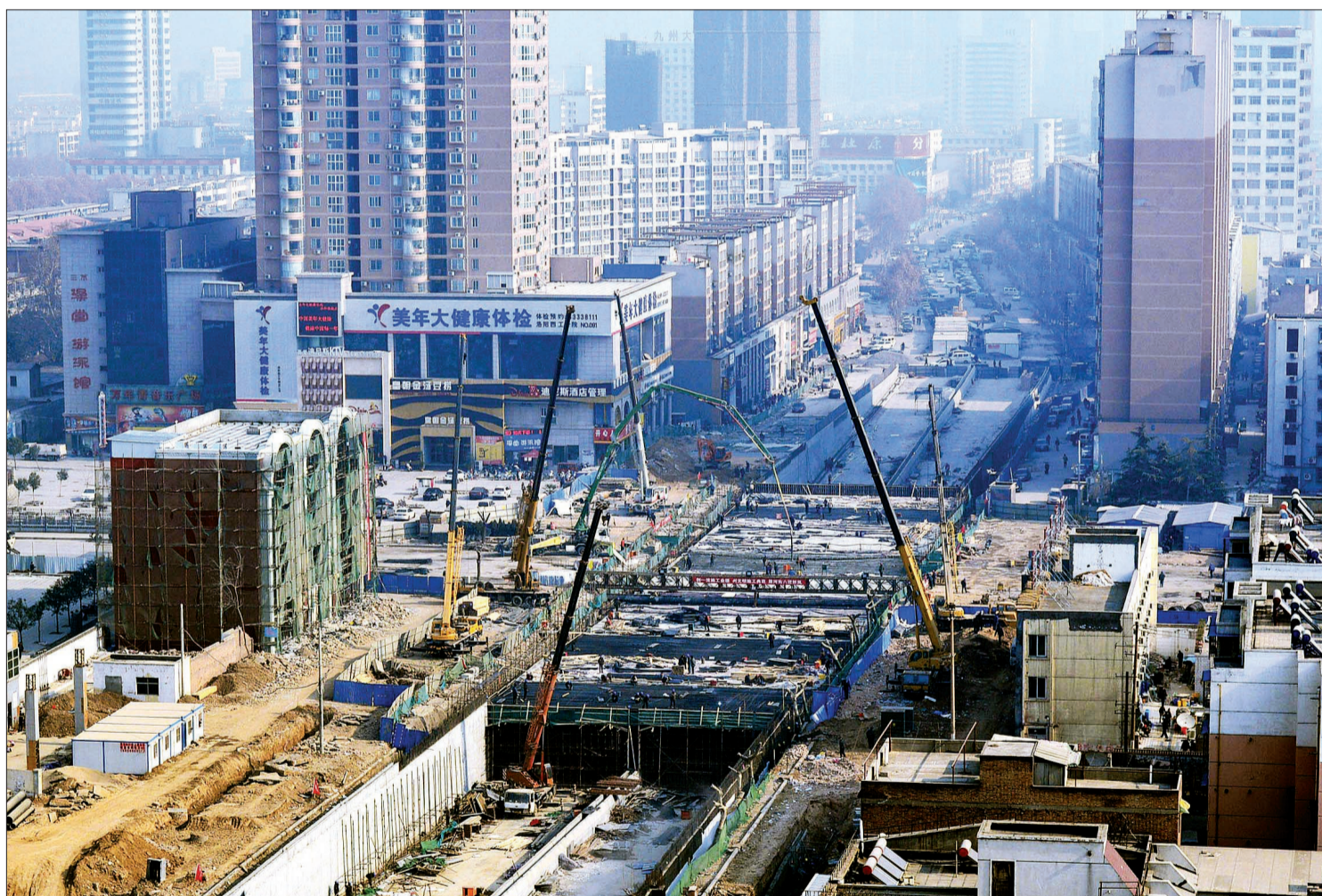
九都路下穿解放路立交工程施工现场
