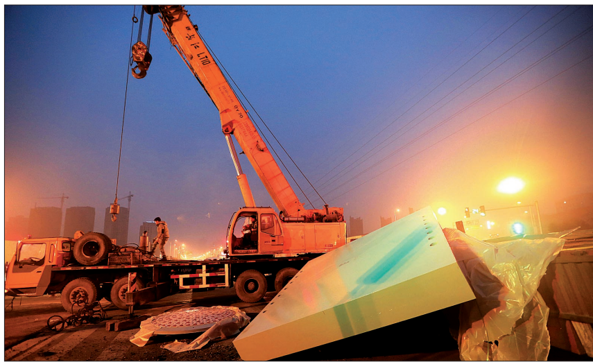
吊车准备起吊桥梁支架
