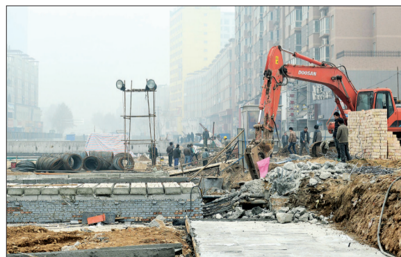
昨日,在改造建设中的九都路下穿解放路框架桥施工现场,施工人员进行紧张施工,力争早日建成通车。记者 李卫超 摄
